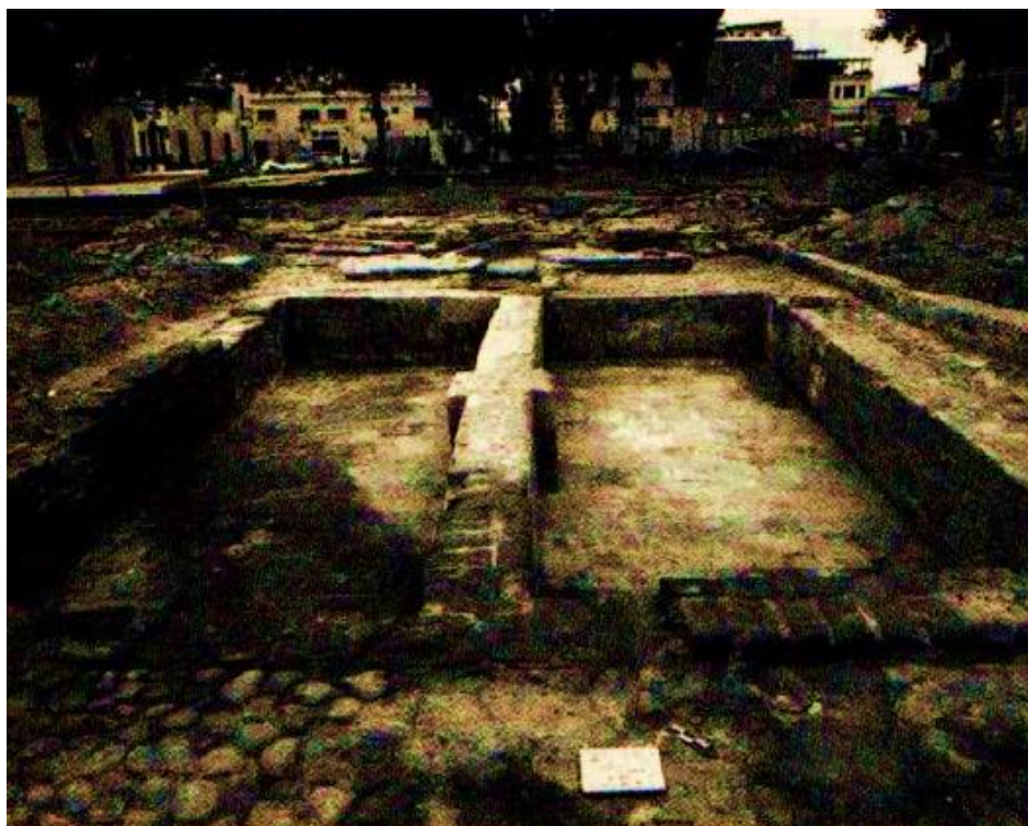
Figura 4. Vista sedimentadores estanque de agua Carcelén et al. (2016)
